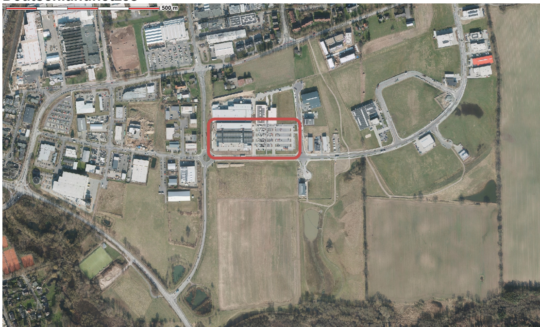
Abb.: Voraussichtlicher Standort des Ladehubs im Rahmen des Deutschlandnetzes
