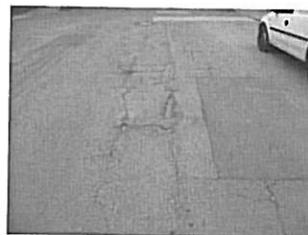
**Mikrorisse**, gealterter Asphalt und die Temperaturbedingungen bei der Herstellung
