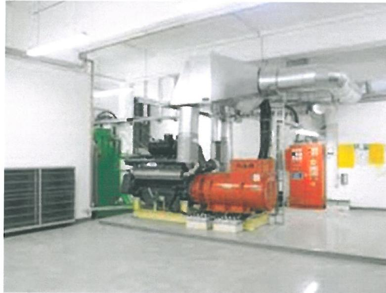
Stationäre, festverbaute **Netzersatzanlage** zur Aufrechterhaltung der Arbeitsfähigkeit des Rathauses im Krisenfall. Im Falle eines Stromausfall gleich welcher Art und Dauer, schaltet sich die Netzersatzanlage selbsttätig ein und versorgt die Hauptstromkreise (Datenserver, Arbeitsplätze, Notbeleuchtung) im Rathaus.
